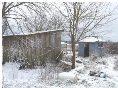
Koka konstrukcijas šķūnis
